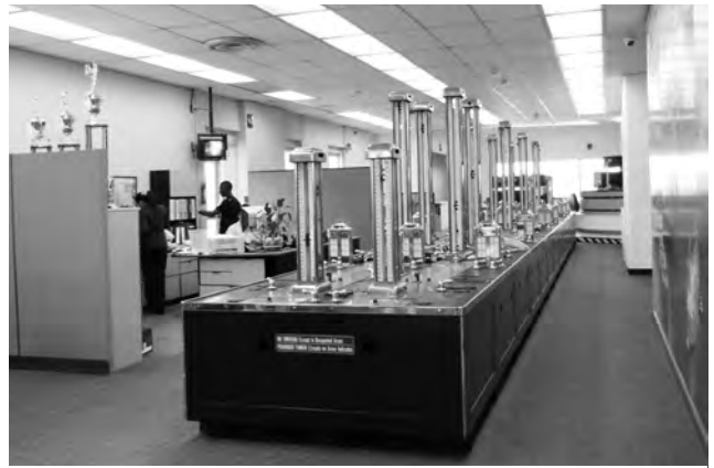
(写真2) ミラフローレス閘門制御室
